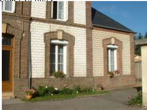
Logement de fonction : à droite la partie rajoutée
