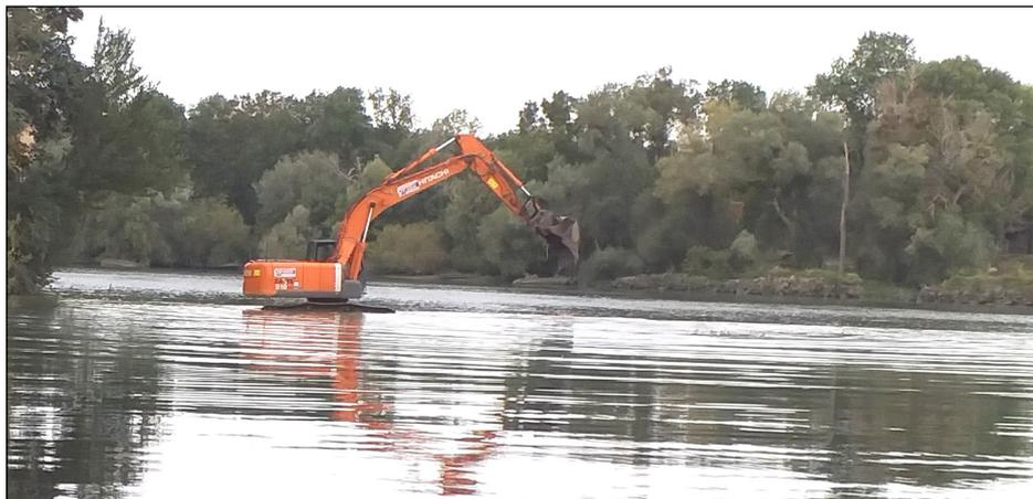
Une pelleteuse en action à Pont de l'Arche pour construire une digue afin de supprimer la confluence de l'Eure avec la Seine et permettre à tout le débit de l'Eure de couler vers Martot
