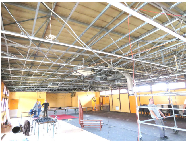
Début des travaux de rénovation thermique à la salle communale et à la cantine
