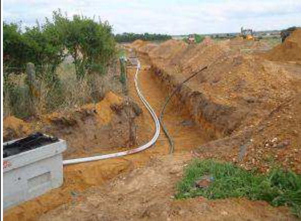
La première phase des travaux de viabilité du lotissement « La Roselière » ( réseaux électricité, éclairage public, eau, gaz, assainissement eaux usées et eaux pluviales, parking et voirie provisoire) est terminée.
