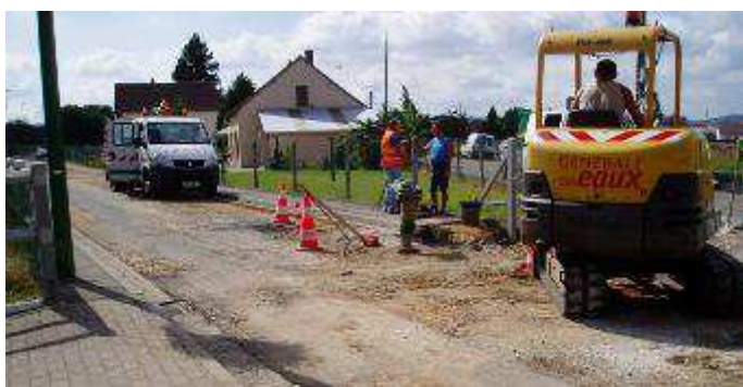
Aménagement de sécurité rue de St Pierre
