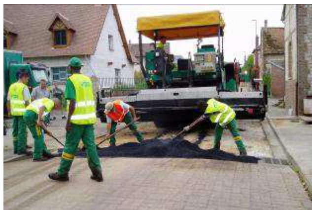
Réfection de la chaussée rue de la mairie après les travaux sur le réseau d'eaux pluviales
